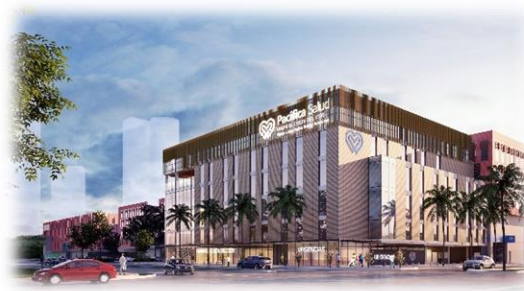
Figure 2 Costa Del Este Hospital - 2022
